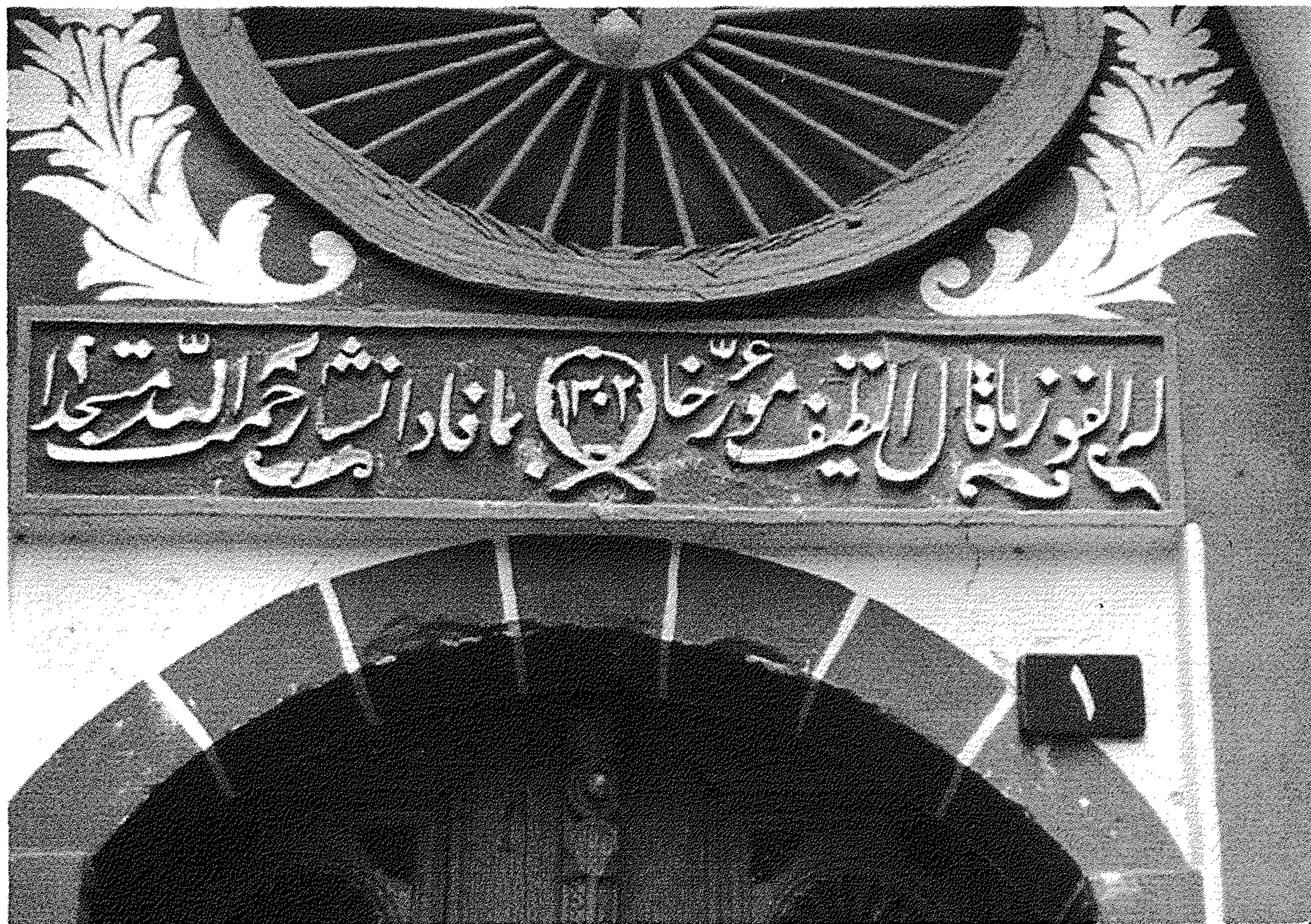
لوحة رقم (٥) : منظر تفصيلي لأخر بيت من القصيدة المنقذة بواجهة مدخل مسجد الشيخ رحمت الله
